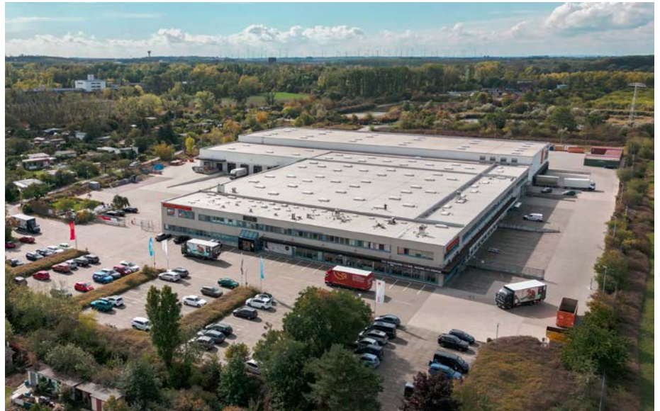
Blick über das Firmengelände der HS-C. HEMPELMANN SCHÖNEBECK KG
